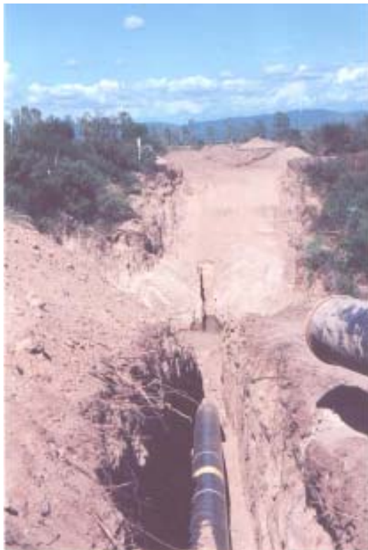
FOTO 2: Zanjeo abierto antes de instalación de tuberías (Torzalito).
