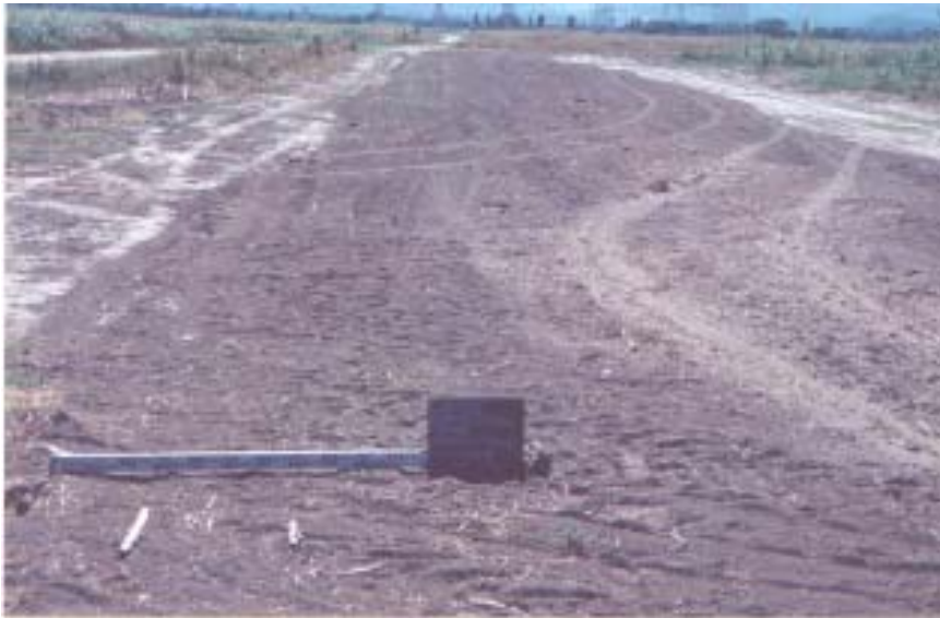
FOTO 1: Pista de Gasoducto cubierta y consolidada después de instalación de tuberías.
