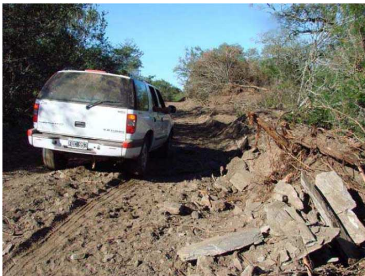
Figura 8. Parque La Tunita. Impacto producido por la construcción de una huella en abril de 2007.
